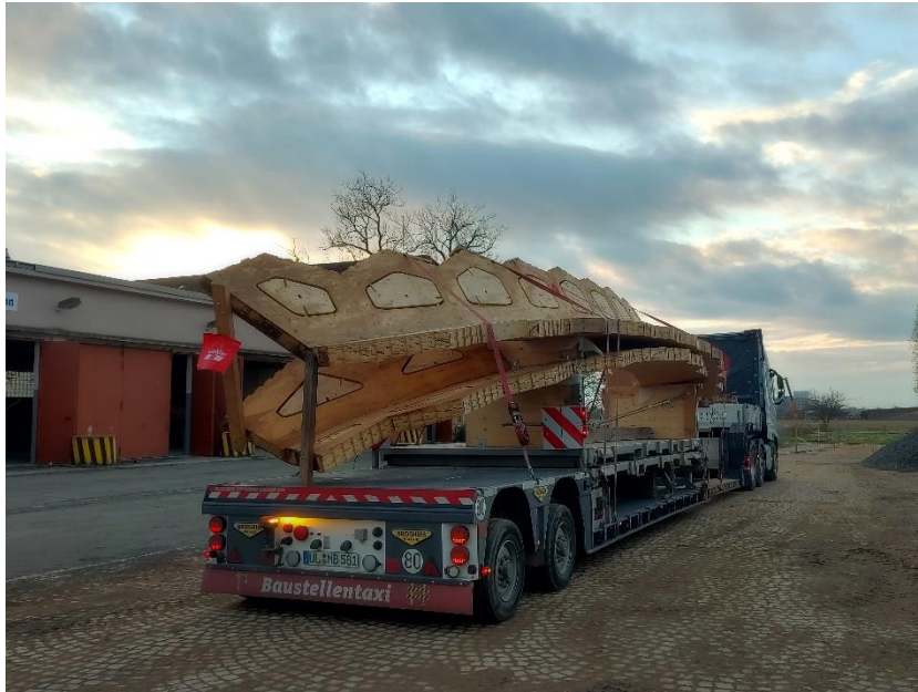
Die Stützbögen des MRN-Pavillons wurden in den letzten Tagen auf dem Spinelligelände angeliefert. Bild: BUGA 23
