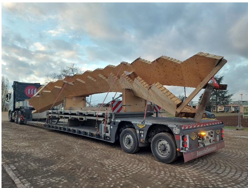
Die Stützbögen dienen der seitlichen Stabilisierung der wabenförmigen Segmentplatten. Bild: BUGA 23
